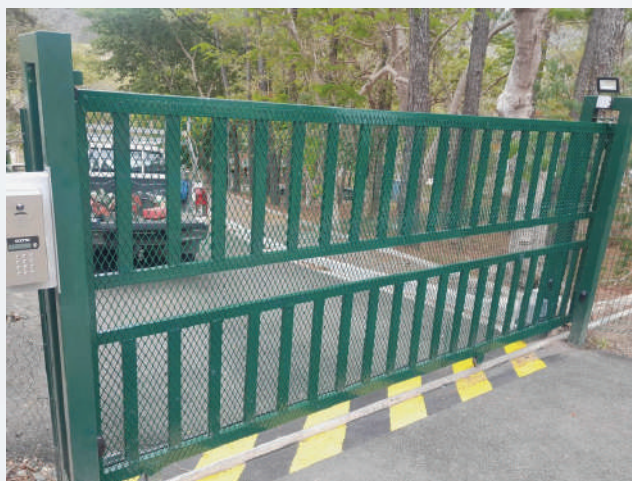
Pose d'un portail électrique- Lycée professionnel ALP - Commune de La Foa
