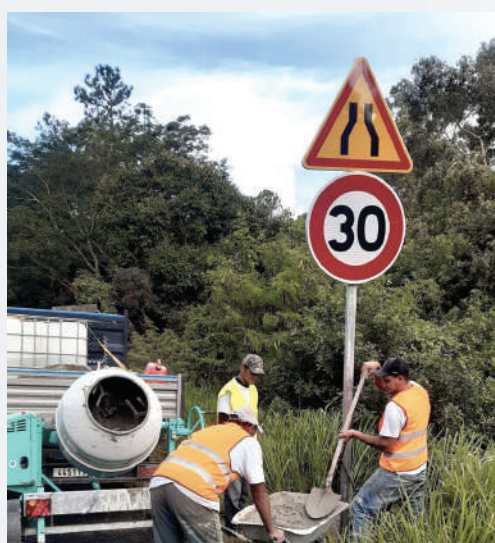
Pose de signalisation verticale Province Sud
