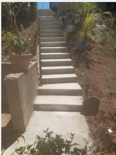
Réalisation d'un escalier - SIC
