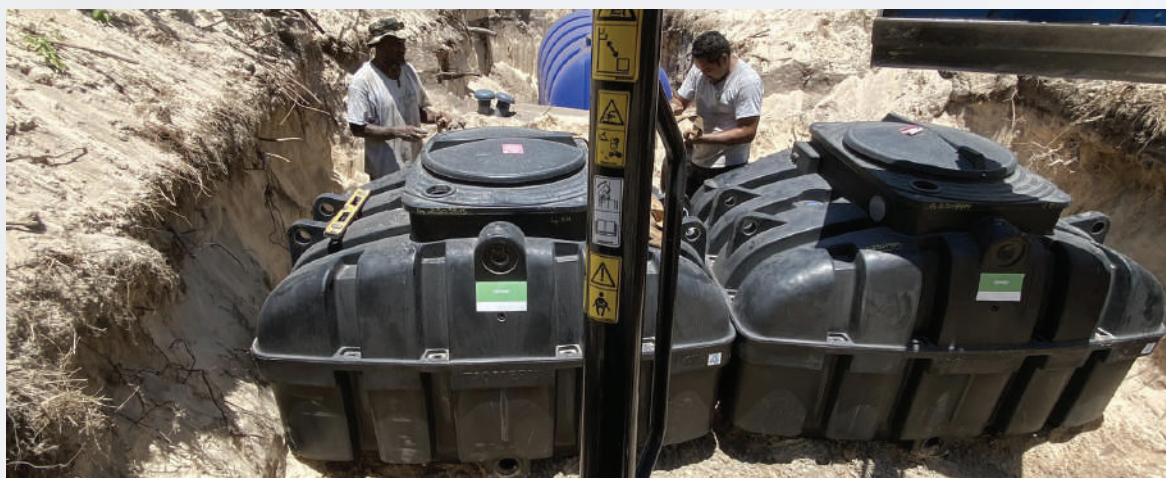
Pose de fosses septiques - Plage de Poé - Domaine de Guaro Deva
